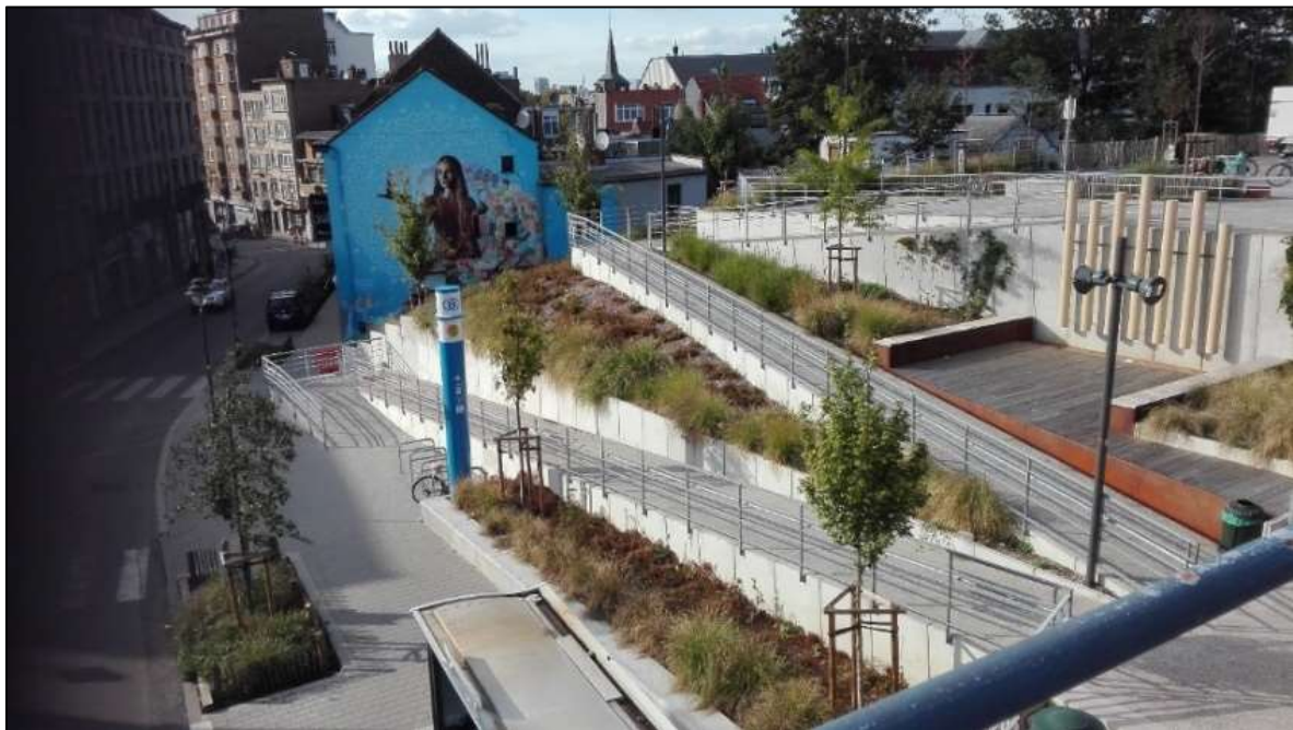
10 Herinrichting van de toegang tot station Vorst-Oost (@ Gemeente Vorst – 2022)
